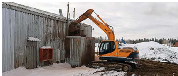
Загрузка буровых шламов на переработку в УТД-2
